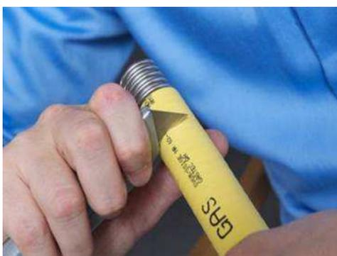
Snij met een cutter over een lengte van ongeveer 2,5 à 3 cm de PE mantel weg.
